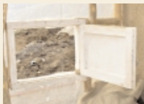
La surchauffe dans la serre est maîtrisée grâce à des trappes de ventilation naturelle
